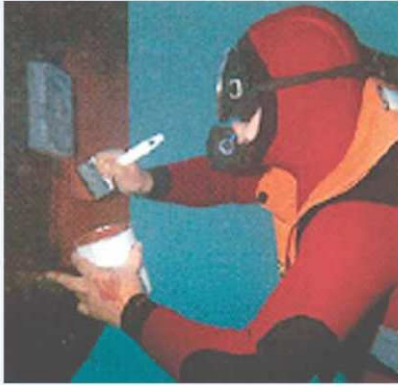
Reparações subaquáticas na zona dos ânodos.
