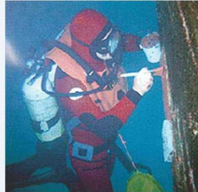
Complementando à proteção anticorrosiva.
